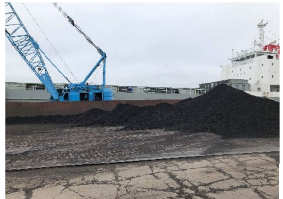
現在の発電所側の港の様子。海外産の石炭が大量に運び込まれるようになった。地産地消を売りにしていた釧路火力発電所の燃料が
