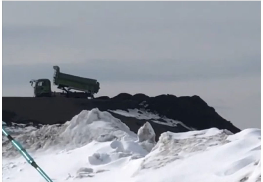
3月1日 焼却灰の銘板を付けた大型トラックが発電所敷地内で積載物を廃棄。鼻がツンとなる異臭がする
