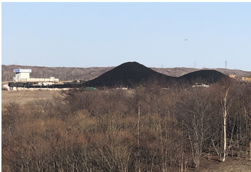
桜ヶ岡ヒルトップの貯炭場。釧路港から大量の海外炭が運び込まれています。ここから発電所に石炭が供給されています。
